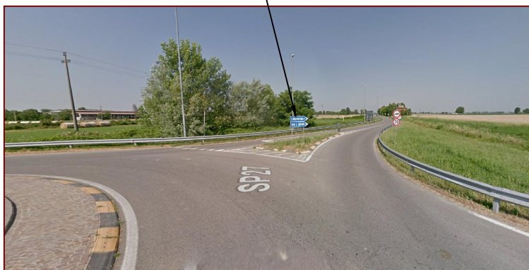
installazione del preavviso temporaneo in luogo dei cartelli di direzione sfruttando i sostegni esistenti
