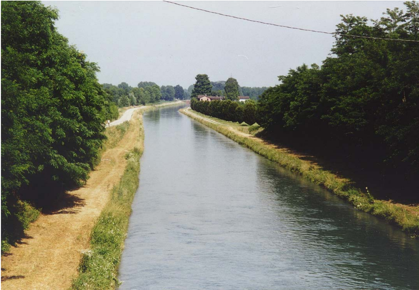
P060-06 – Il Canale Vacchelli ripreso dal ponte della S.P. n. 71, in località Villa Merlata: nelle vicinanze andrebbe costruito il ponte della ferrovia nella variante A.
