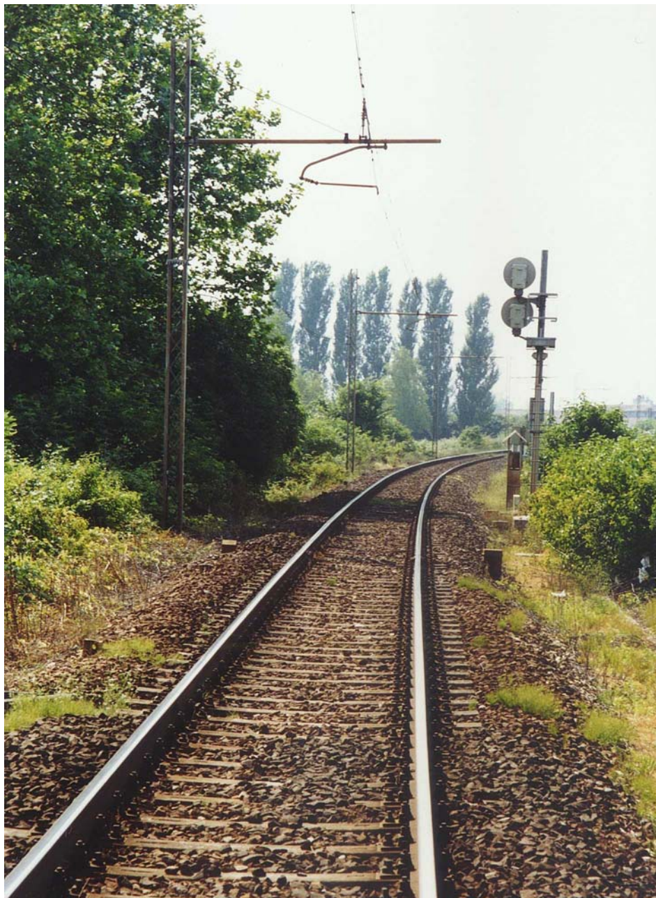
P060-03 – Ferrovia Treviglio–Crema–Cremona, ripresa in direzione di Treviglio nella zona del bivio previsto con la variante di tracciato A.
