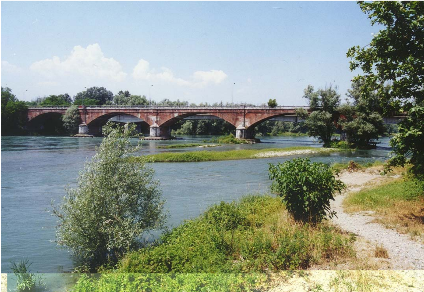
P060-11 – Il vecchio ponte sull'Adda della S.S. n. 415 e il nuovo ponte (che s'intravede dietro il vecchio), ripresi da sud, presso il punto individuato per l'attraversamento del fiume.
