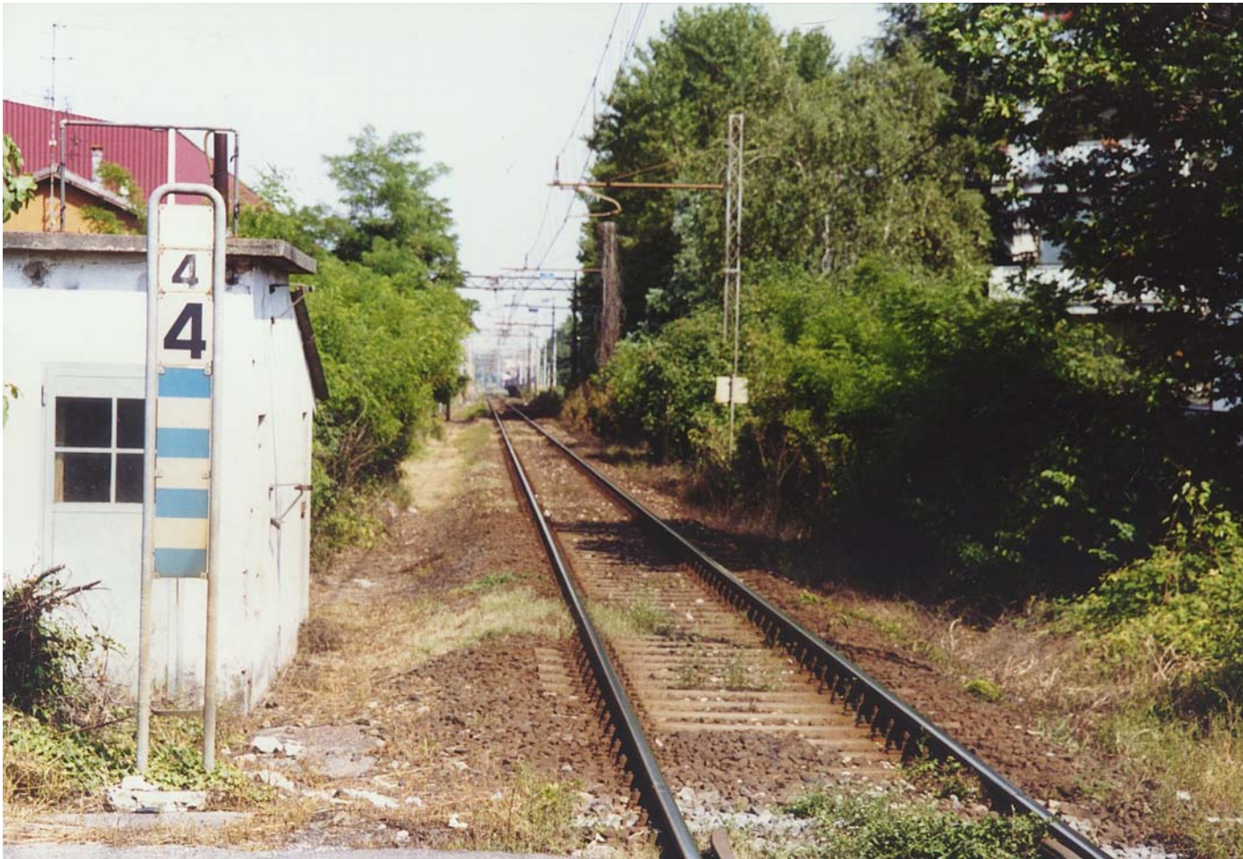
P060-02 – Crema: sede della ferrovia da Treviglio, ripreso dal PL di via Indipendenza in direzione della stazione. La sede dovrebbe essere allargata sui due lati per realizzare il secondo ed eventualmente il terzo binario.
