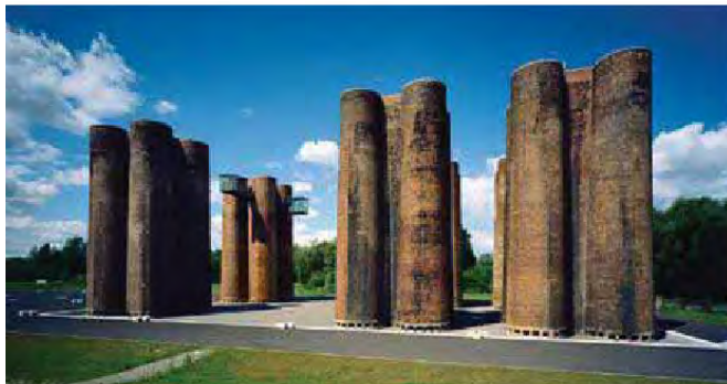
torri in laterizio
