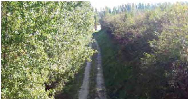
barriera realizzata con terrapieno e vegetazione arbustiva
