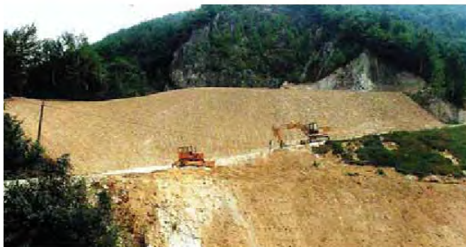
località Giardiniet prima degli interventi di recupero
