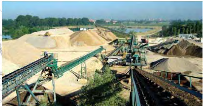
l'area da rinaturalizzare vista dalla zona degli impianti
