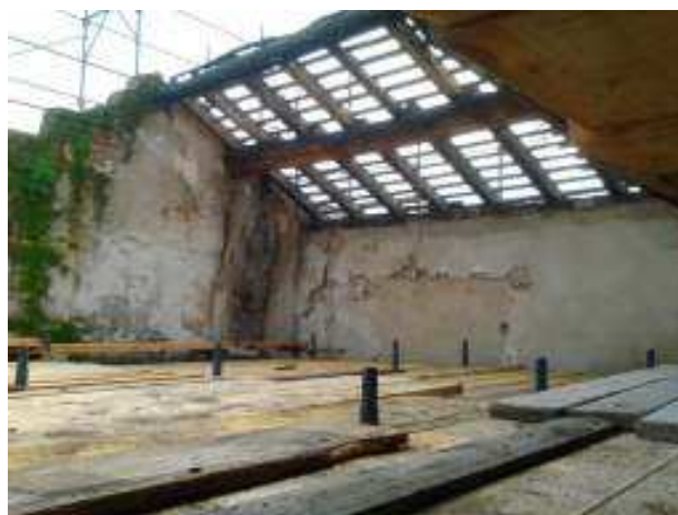
Lo stato delle terzere prima dell'intervento
