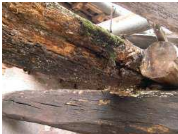
Stato di degrado dell'orditura primaria
