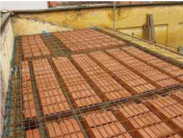
Realizzazione delle murature e del solaio
