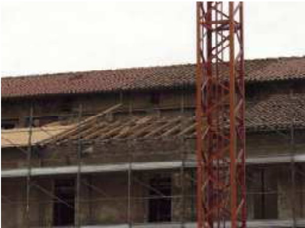
Smontaggio della vecchia copertura
