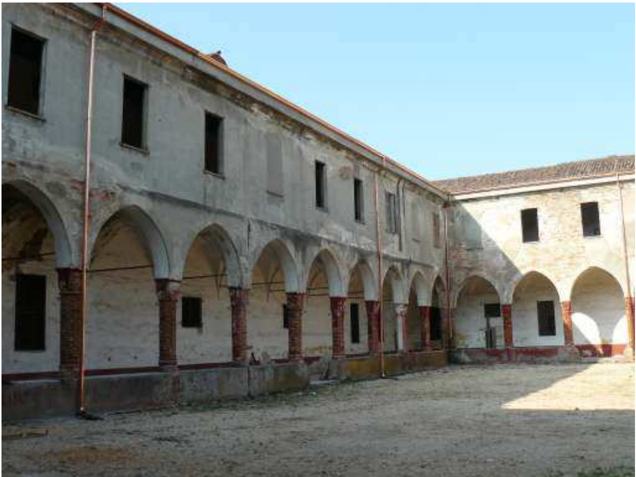
La copertura a lavori ultimati
