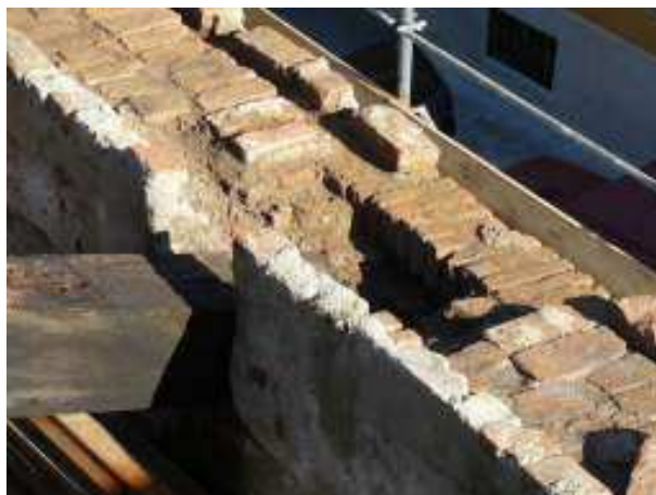
La gronda dopo lo smontaggio della copertura
