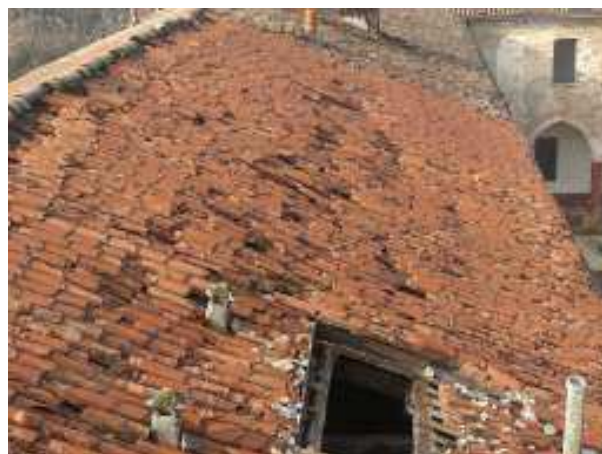
Stato di degrado della copertura
