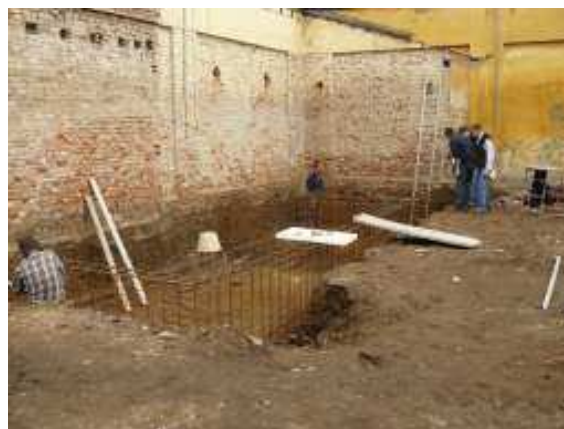
Scavo per le fondazioni del nuovo fabbricato
