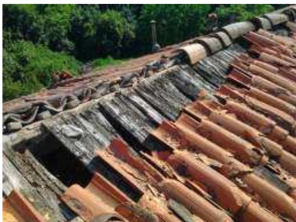
Stato di degrado dell'orditura interna
