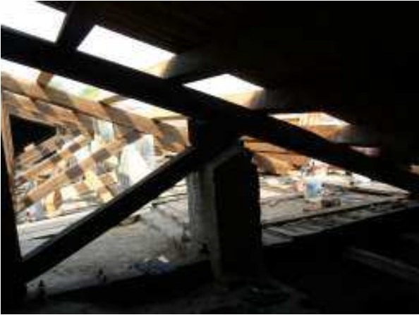
Smontaggio della vecchia copertura
