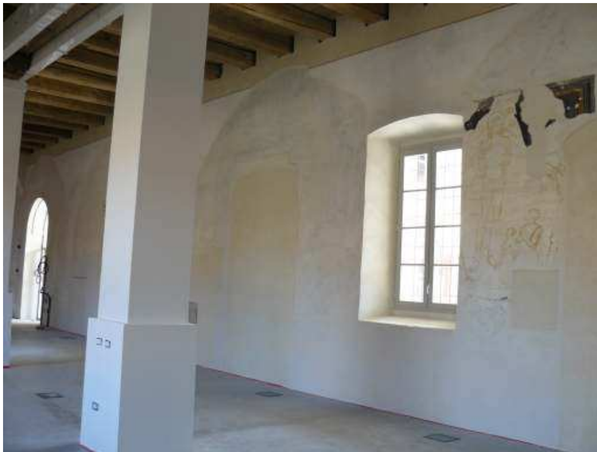
il salone grande del piano terra (chiesa provvisoria tra demolizione vecchia chiesa e nuova chiesa)
