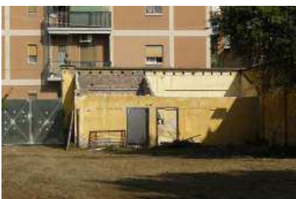
Demolizione del vecchio fabbricato
