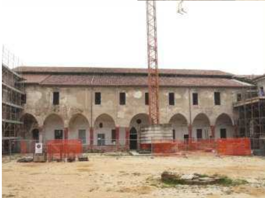
La copertura a lavori ultimati
