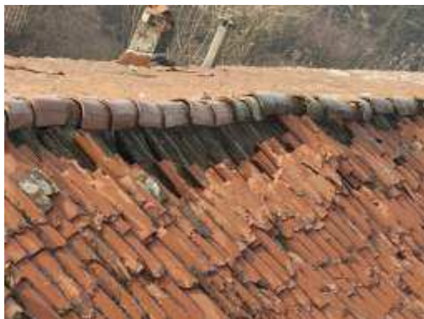
Stato di degrado della copertura
