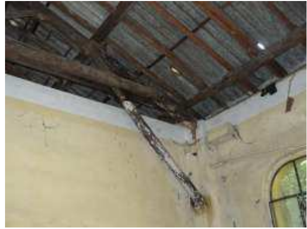
La vecchia copertura in lastre di cemento-amianto
