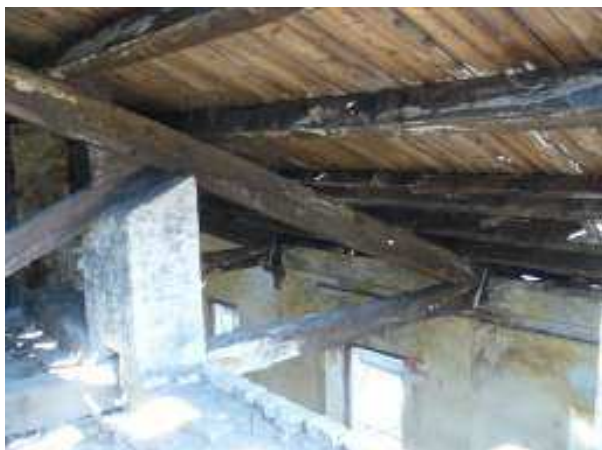
Stato di degrado dell'orditura interna
