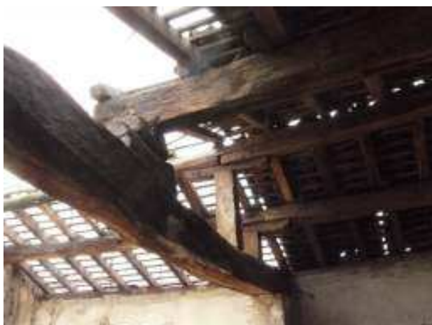
Lo stato delle coperture prima dell'intervento
