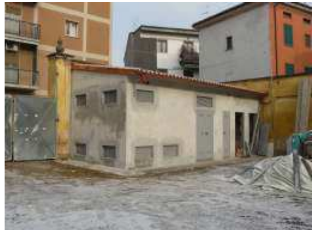
Il nuovo fabbricato prima della tinteggiatura
