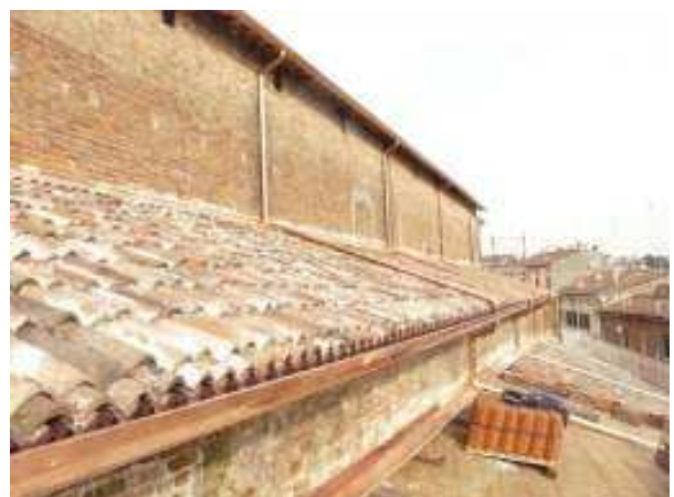
La copertura della navata laterale della chiesa ultimata
