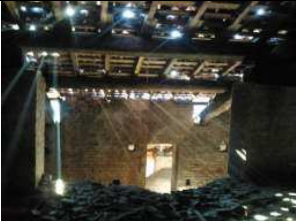
Stato di degrado dell'orditura interna e della copertura
