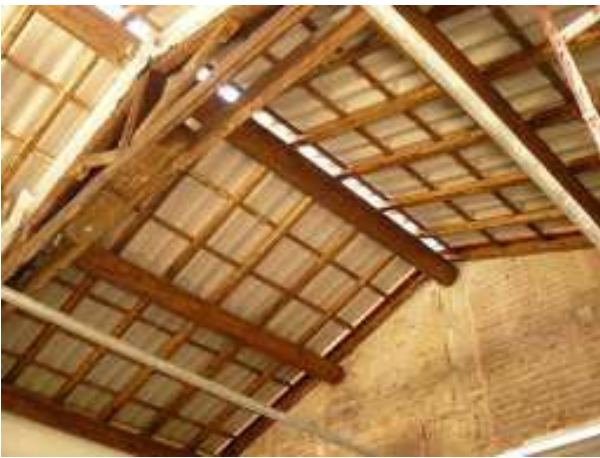
Il nuovo manto di copertura in lastre di fibrocemento
