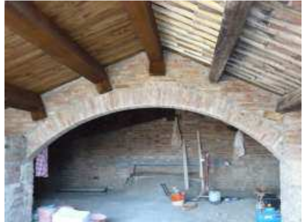
Consolidamento delle murature e dell'arco
