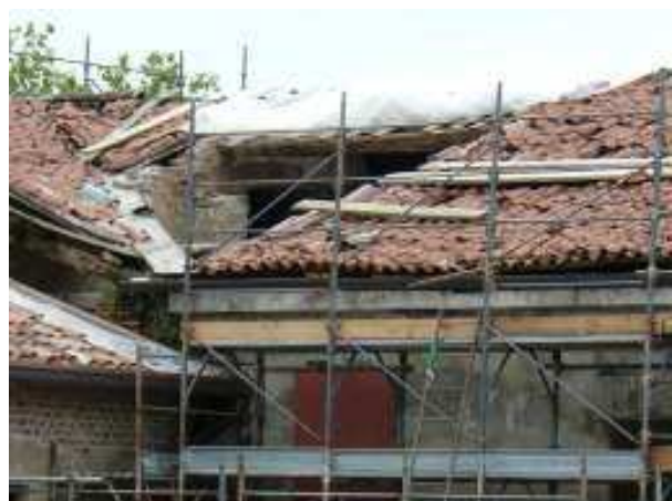
Smontaggio della vecchia copertura
