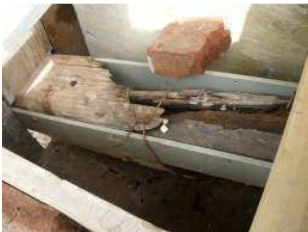
Consolidamento delle capriate
