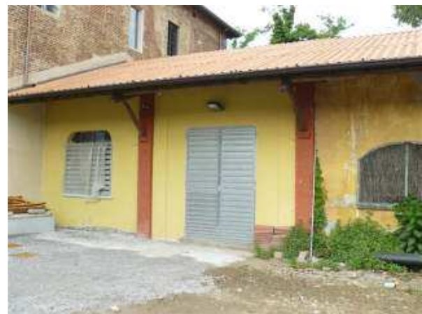
La centrale termica a lavori ultimati
