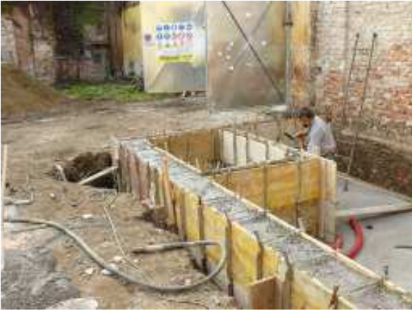
Le fondazioni in c.a del nuovo fabbricato
