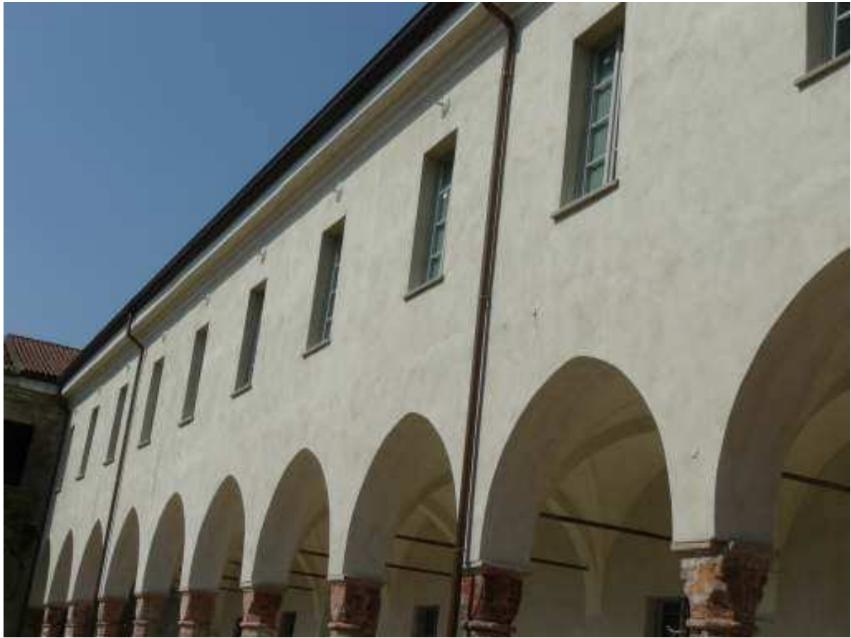
il prospetto sud dell'ala dell'ex monastero
