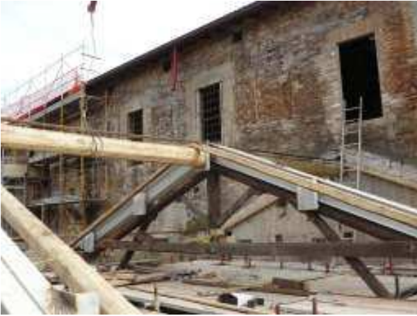
Le capriate dopo il consolidamento
