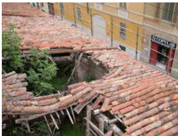
Stato di degrado dell'orditura primaria
