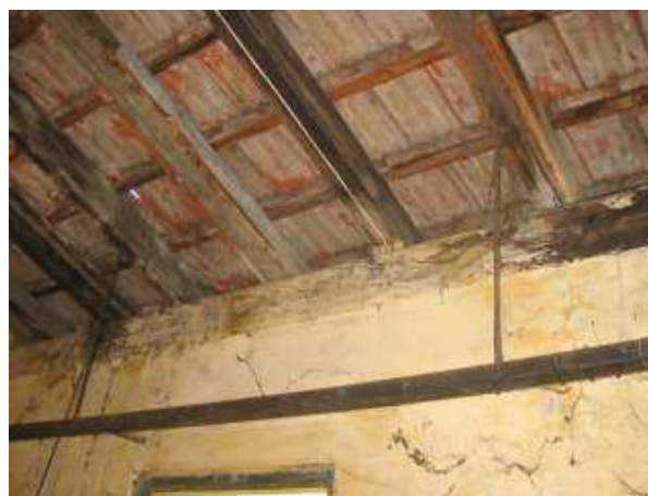
e dell'orditura del tetto
