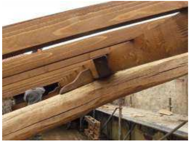
Sistemazione dei vecchi puntoni e posa orditura
