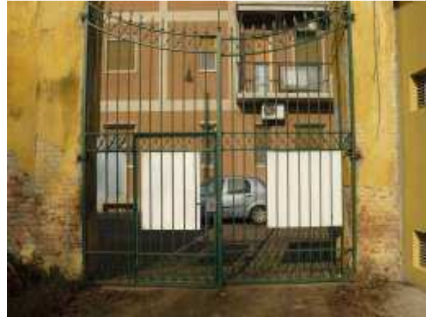
Il cancello dopo l'intervento
