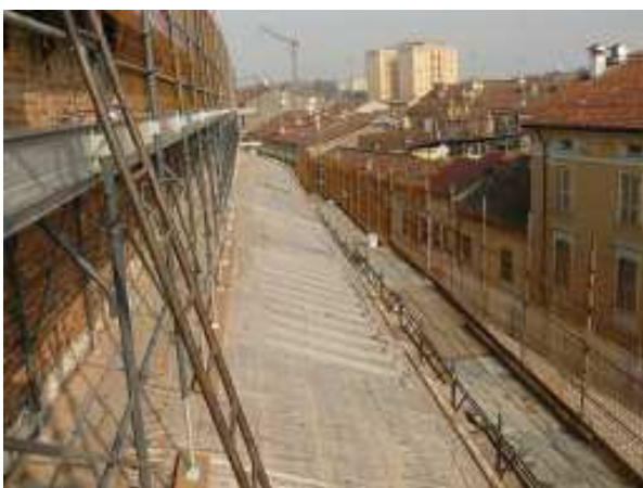
Completamento della copertura
