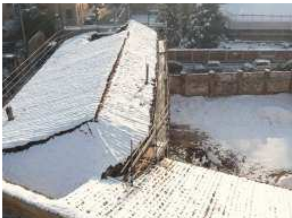
Vista della copertura prima dell'intervento
