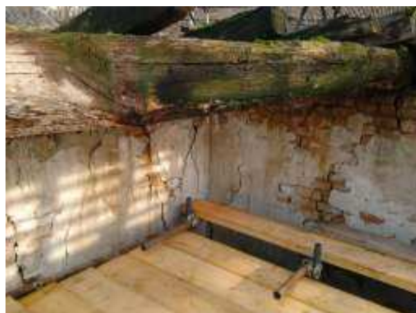
Lo stato delle terzere prima dell'intervento
