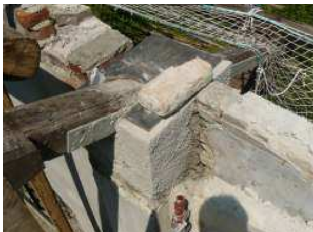
I puntoni delle capriate prima del consolidamento
