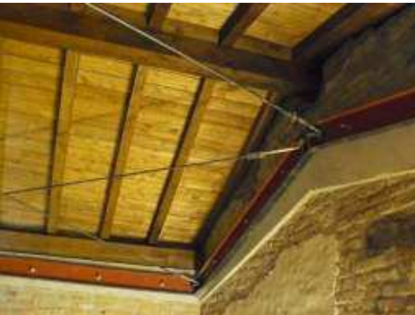
Dettagli delle tirantature
