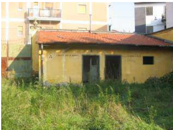
Il fabbricato prima dell'intervento
