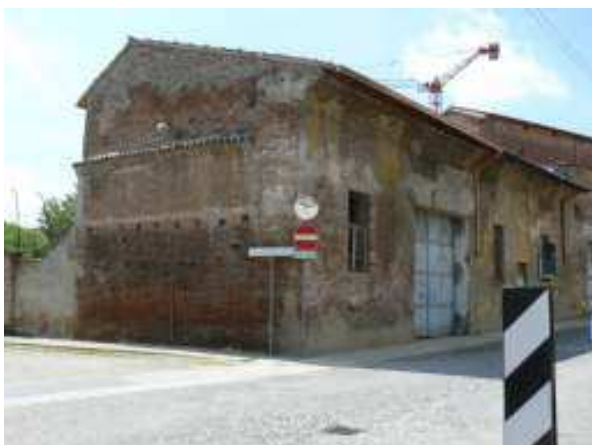
La copertura a lavori ultimati
