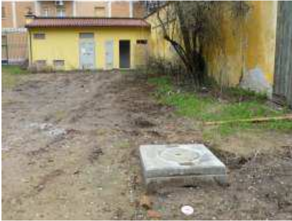
Il nuovo fabbricato a lavori ultimati
