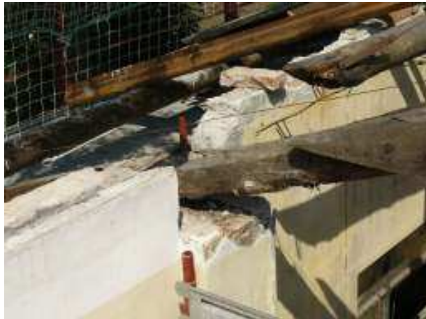
I puntoni delle capriate prima del consolidamento
