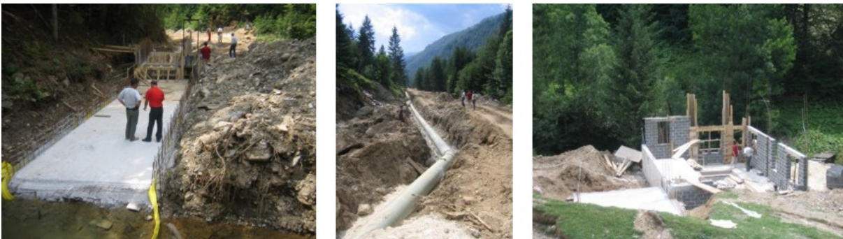
Figura 2.5. Centrale idroelettrica di piccole dimensioni in costruzione sul Fiume Prusacka presso Vranica Mountain – Preso d'acqua, condotta forzata, centrale elettrica
